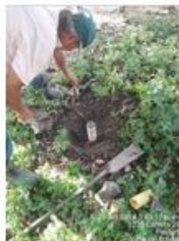
Cambio de Aspersores
